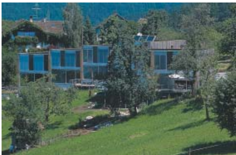
Passivhaus-Reihenhausanlage in Zwischenwasser
