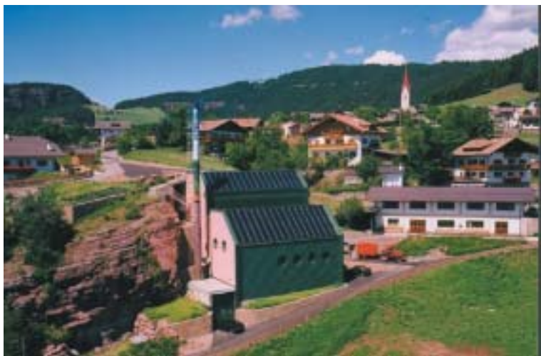
Biomasse-Heizzentrale in Vöran
