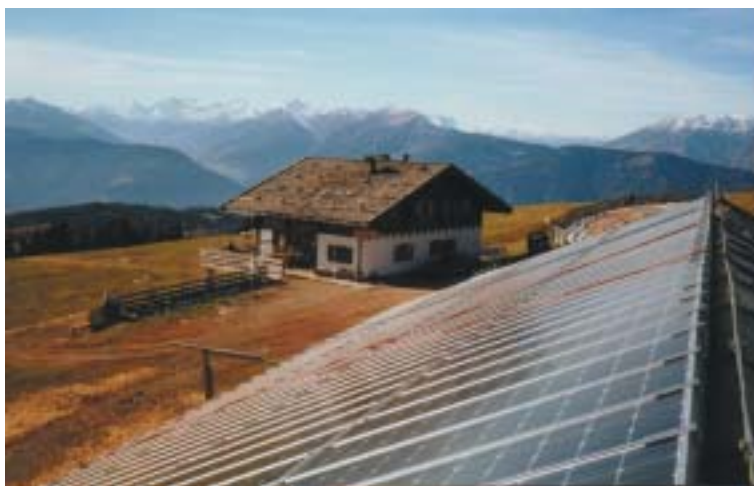
Fotovoltaik auf der Alm in Vöran
