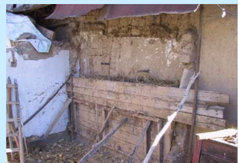
Travaux d'isolation sur une maison kirghize
