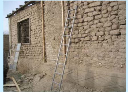
Travaux d'isolation dans le village de Tamchi/Kirghizstan, membre de l'AGOCA
