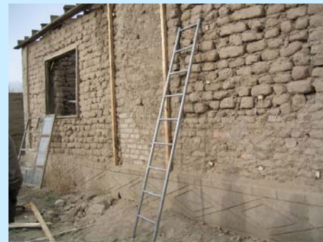
Interventi di coibentazione nel villaggio di Tamchi/Kirghizistan, membro dell'AGOCA
