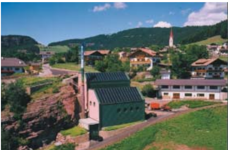
Centrale di riscaldamento a biomassa a Verano
