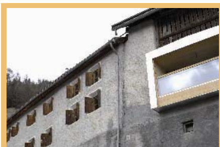
La façade du « Piz Tschütta ».
