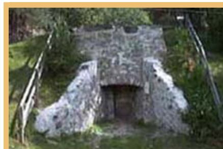
Questo forno da calce si è conservato e nel 1988 è stato restaurato dalla “Società d'Util public”.
