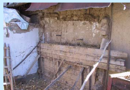
Izolacijska dela v eni od kirgiških hiš
